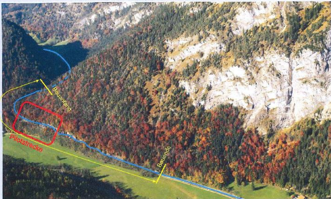
B21: Ertüchtigung der Stützmauern am Bodenbergl
