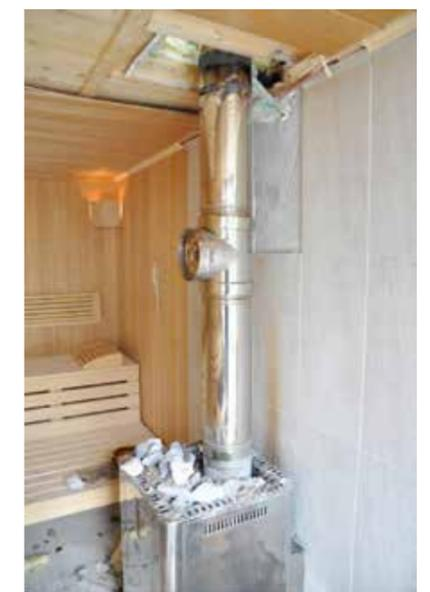
Der Saunaofen mit Abgasrohr
