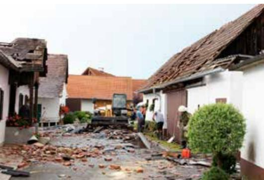
letzten Jahre kann man erkennen, dass neben Schäden durch Hagel und Schneeeindruck die Sturmschäden rund 44 Prozent des Gesamtanteils ausmachen. Vor allem durch einwirkende Windsogkräfte werden neben der Dacheindeckung oft ganze Dachtragwerke bzw. Dachkonstruktionen abgetragen und können so zum tödlichen Geschoß werden.
